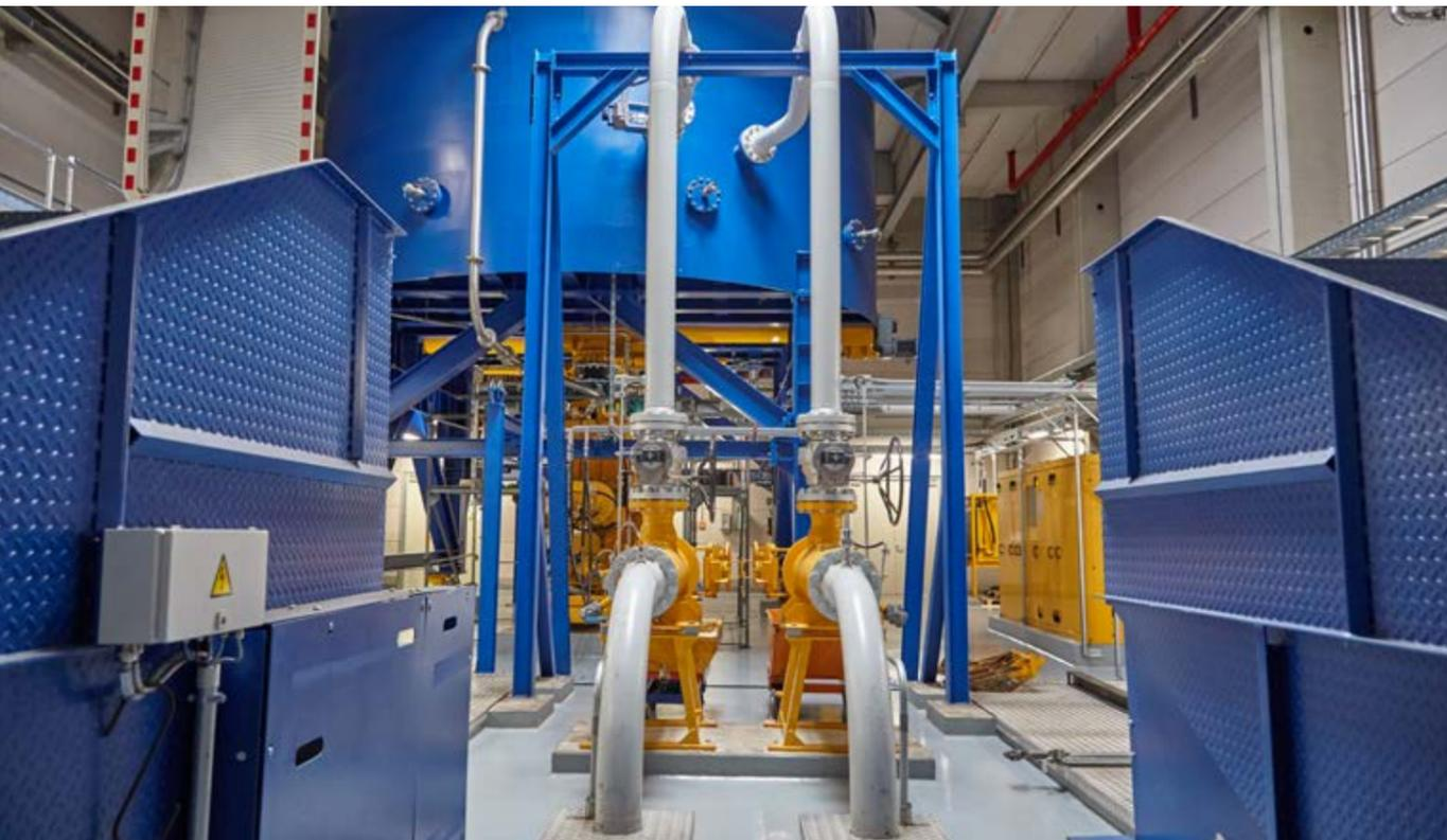
Fremdkörperabscheidung vor der Beschickung des 1.000 m<sup>3</sup> Speichersilos
